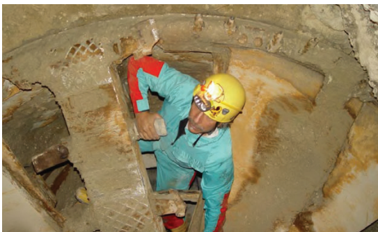
Si passa attraverso i denti della "talpa" per accedere ad una cavità rinvenuta nel corso dello scavo di un collettore (foto: Marco Vitelli)
