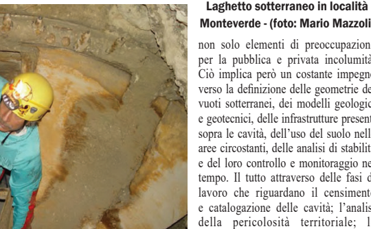
Si passa attraverso i denti della "talpa" per accedere ad una cavità rinvenuta nel corso dello scavo di un collettore (foto: Marco Vitelli)
