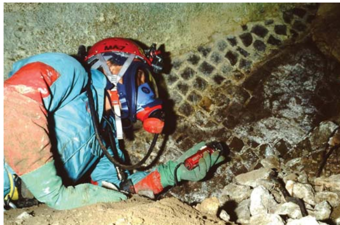
Foto: Marco Vitelli - Tecnico ASSO si addentra nel sottosuolo di una antica struttura, protetto da un autorespiratore a causa della presenza di elevate percentuali di anidride carbonica
