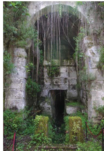
La monumentale opera di captazione, incile, dell'acqua del lago (foto Mario Mazzoli)
